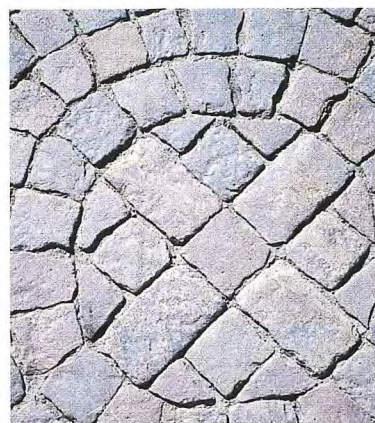
Noppakivet soveltuvat parhaiten kaari- ja ympyräladontoihin, joissa kivet sitoutuvat hyvin toisiinsa.
