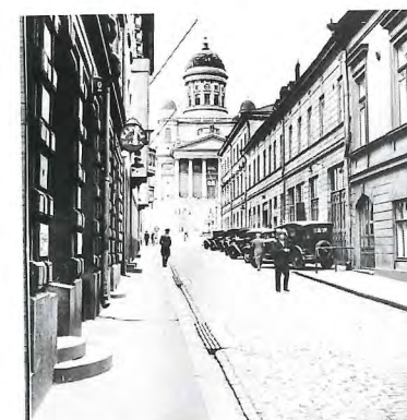
1900-luvun alussa jalkakäytäviä alettiin päällystää asfaltilla. Sofiankatu noin vuonna 1940.
