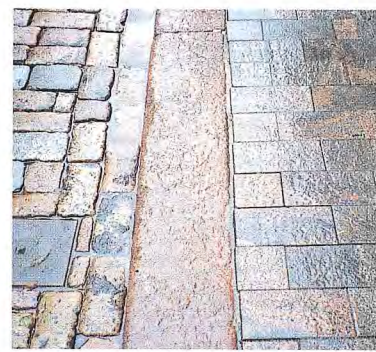
Uusissa laattapäällysteissä käytetty punamusta migmatiitti muistuttaa ulkoasultaan Helsingissä perinteisesti käytettyjä kirjavia kivimateriaaleja.
