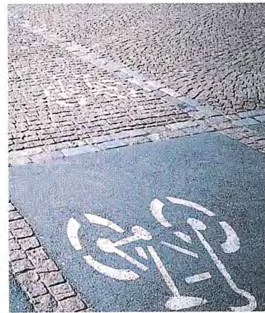
1980-luvun lopulla alettiin Kauppatorin ympäristössä käyttää uusia noppakiviä yhdessä asfaltin kanssa.
