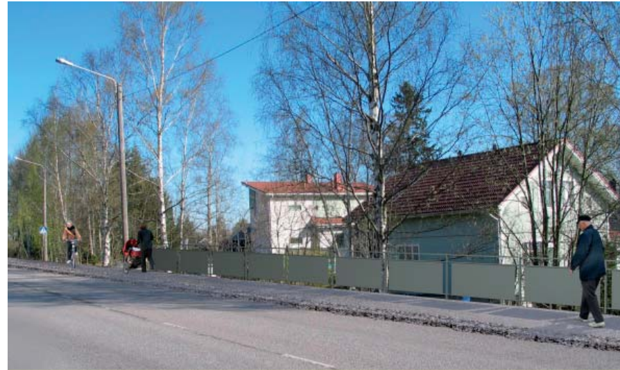
Kuva 5. Havainnekuva laminaattilevyllä varustetun suojakaiteen käytöstä jyrkän pengerluiskan kohteessa.
